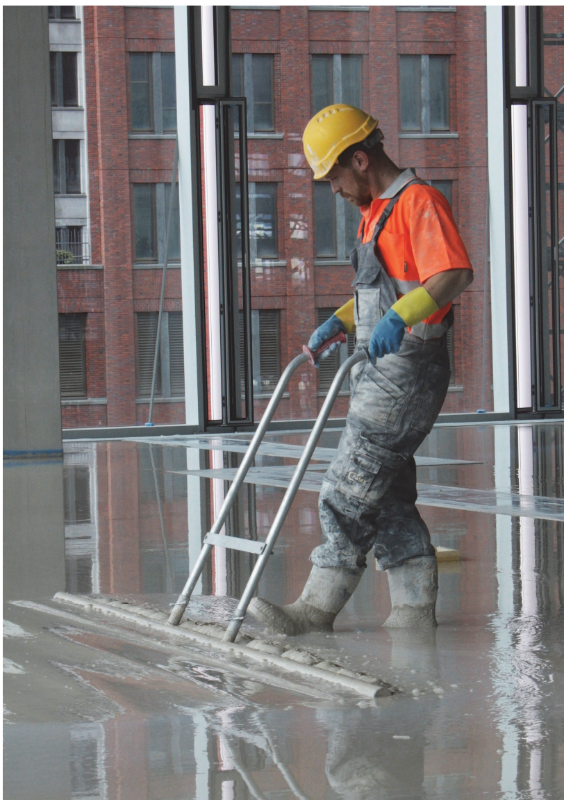
Aanbrengen gietvloer, vlak maken met drijfrei
