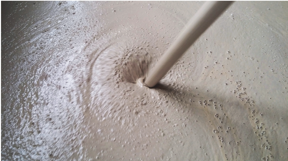
Aanbrengen mortel op de vloer
