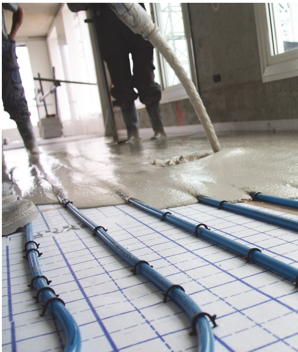
Aanbrengen gietvloer op vloerverwarming
